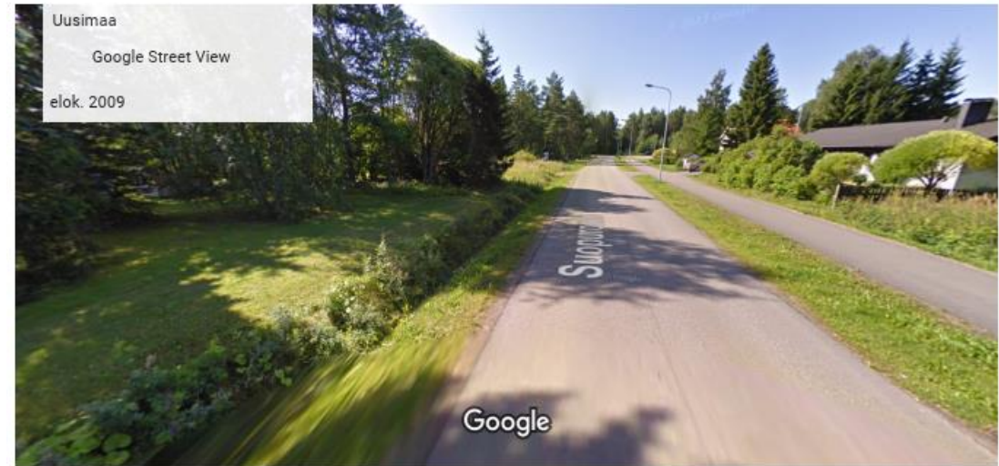
Kuva otettu: elok. 2009 © 2023 Google
